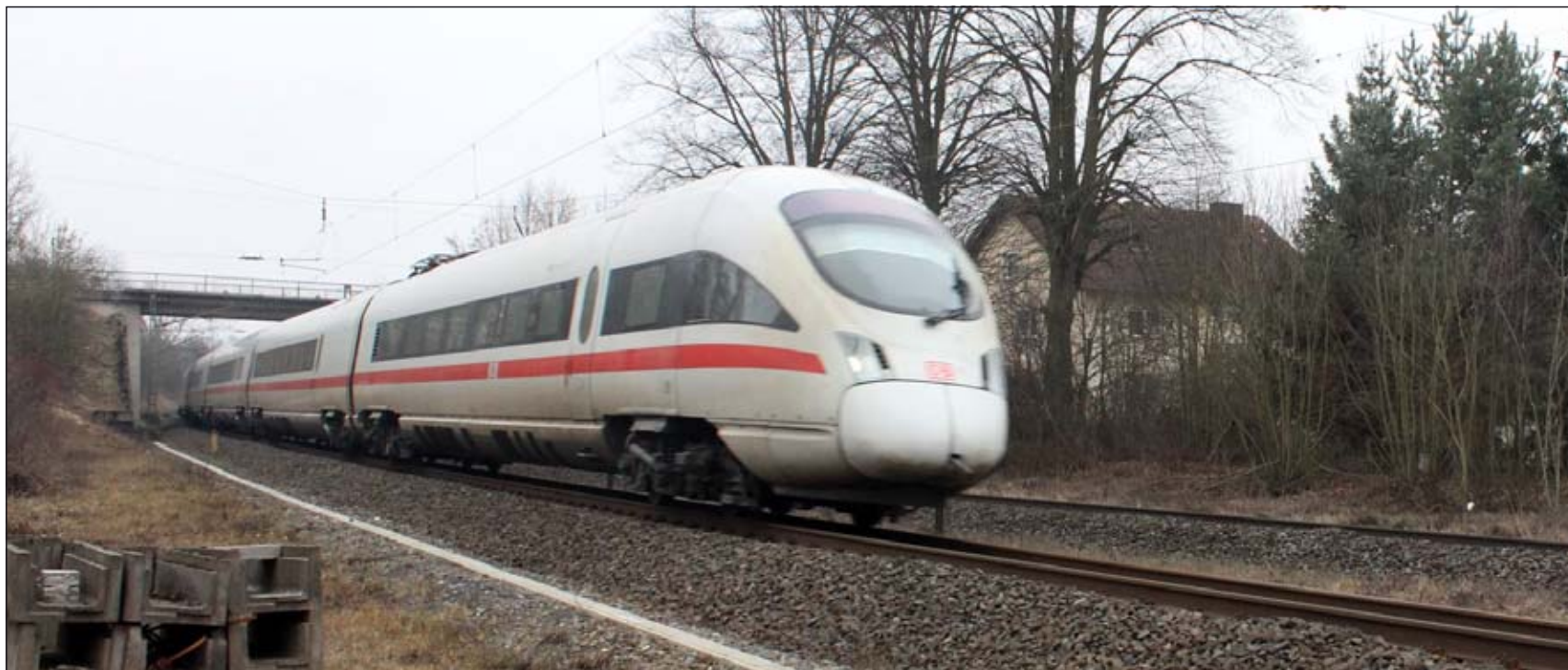
Im Moment verläuft die Zugverbindung zwischen Gelnhausen und Fulda an vielen Stellen ohne Lärmschutzwände direkt an den Wohnbebauungen vorbei. Das Bild entstand in Eichenzell-Kerzell. Bei einem Ausbau der bestehenden Strecke verspricht die Deutsche Bahn einen verbesserten Lärmschutz. ■ Foto: Hiss
